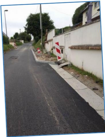
Route de Fort-Moville : travaux réfection faits par CCPAVR, la commune a pris en charge la pose de caniveaux et bordures complémentaires afin d'améliorer les ruissellements sur le tronçon non prévu dans le marché d'entretien C.C.P.A.V.R. Une écluse (passage à sens prioritaire) est en cours de réalisation pour limiter la vitesse dans ce secteur.
