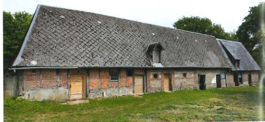
Étable du XIX e siècle, Ferme du Petit Brotonne, Bourneville
